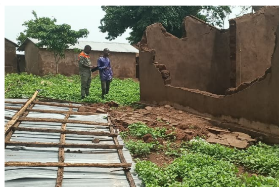
Photo 3 : cas de case décoiffée et écroulée suite aux vents violents dans Lakouda ( Akébou 2 ) le 28/04/2026
